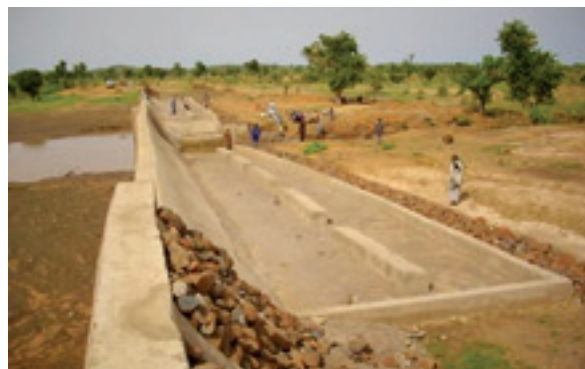
Construction d'un micro barrage hydraulique villageois à Massenya (Tchad)
